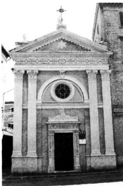
Chiesa della SS. Trinità Facciata (1878)
