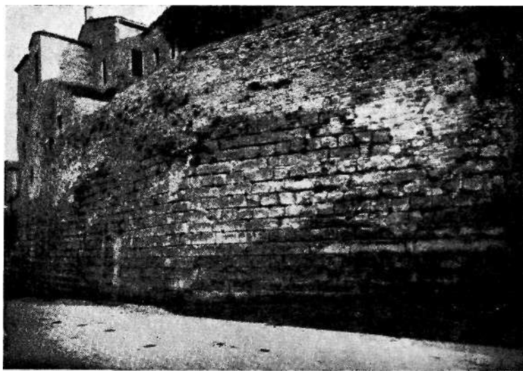
Tratto di mura romana in Via Fonte Magna
